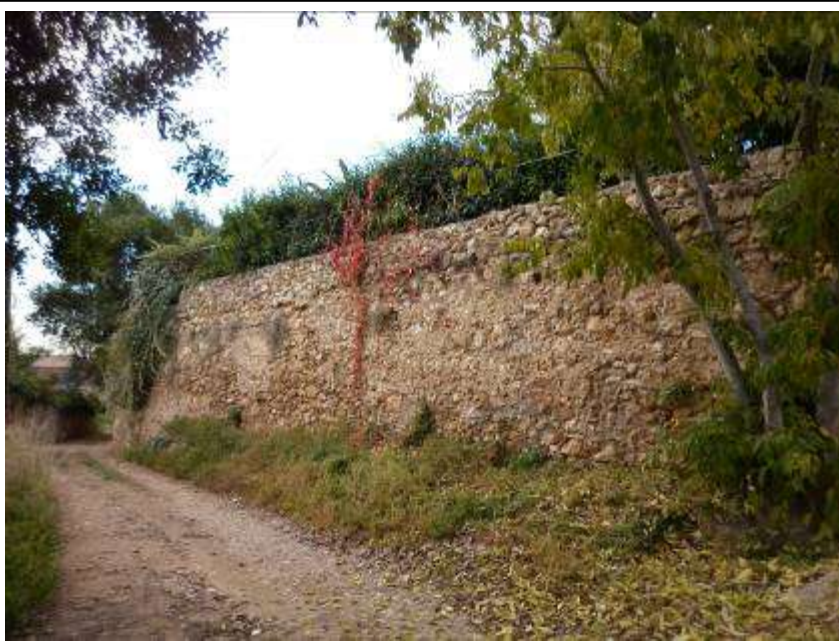
Vista exterior de l'angle i un dels murs del reducte que s'aixeca al mig de la gola del fort. (Foto de l'autor)
